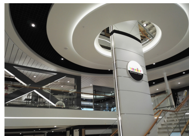
Top Installation rakensi viime vuonna Tallink Megastarin tax-free-myyntialan kattomoduuleja ja rampeja kaikkiaan seitsemään kerrokseen. KUVA: Top Installation
